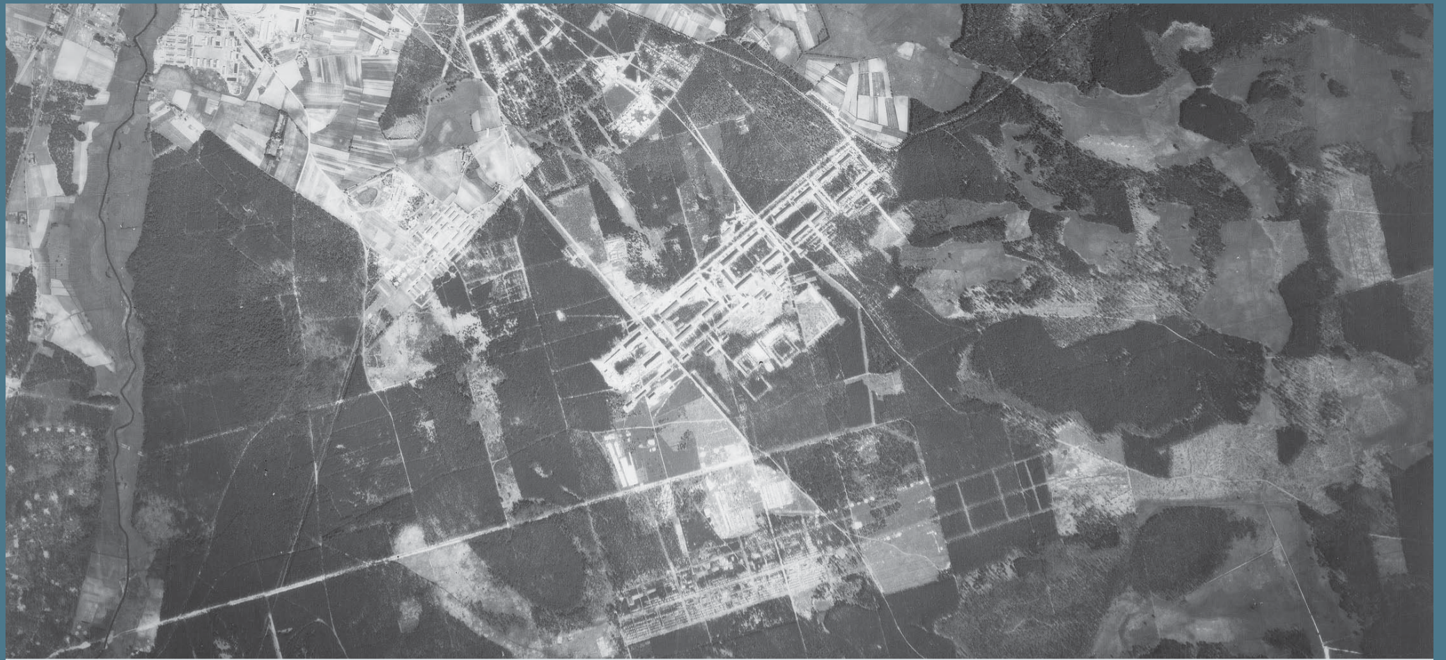
Dieser Ausschnitt der Luftbildaufnahme wurde 1953 wahrscheinlich von der sowjetischen Armee gemacht. Walter Graupner hat sie in Vorbereitung der 800-Jahrfeier der Randowstadt vom Landesvermessungsamt in Schwerin erworben. Die Aufnahme zeigt die Kaserne im Bau und dahinter Hunderte 5x5 Zelte zur Unterbringung der Soldaten. Links oben in den heutigen Gartenanlagen (Teerofen) standen Baracken zur Unterbringung der Bauarbeiter (Dienst für Deutschland).
